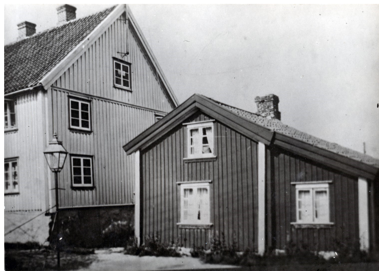
Bild från före branden. Det mindre huset t.h. kallades "Perse-Huset" efter sjömannen Andreas Persson, som bodde här med sin fru Maria Westerberg. Huset var ett av de två hus som sprängdes, för att få stopp på den stora branden 12 maj 1928.
