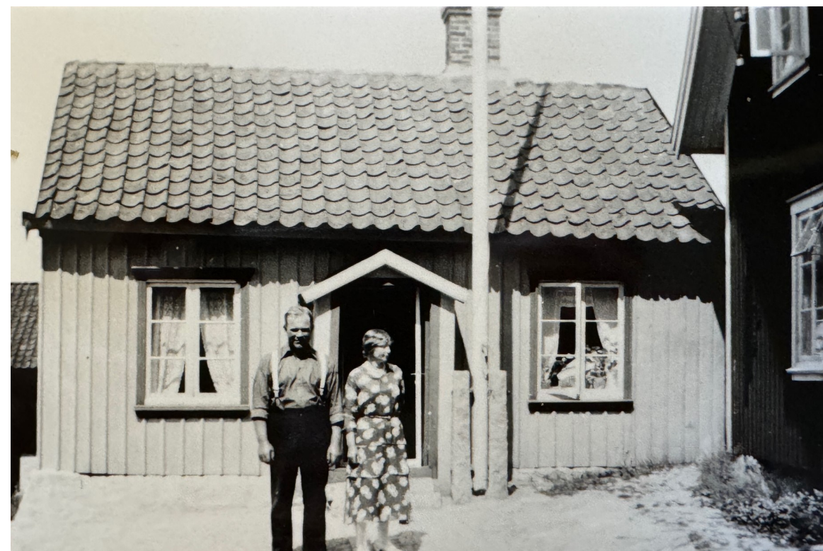
Johan Mjölner och systemen Gunda i juli 1925 - innan huset 1936 flyttades lite på tomten, byggdes om och höjdes. Då tillkom källarvåningen.
