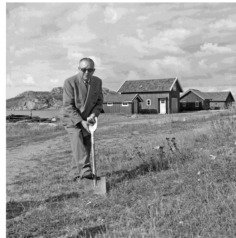
Frank Olsson tar 1957 det första spadtaget till den nya silo-byggnaden.
